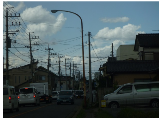
(b) 照明柱（2013年9月2日越谷市）
