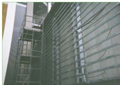
2. 下地架台に灌水ホース敷設
