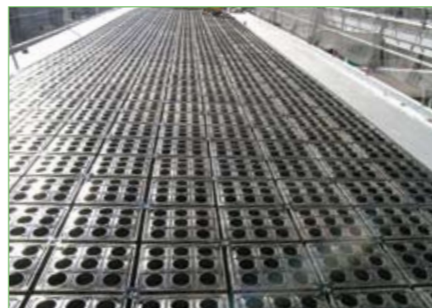
3. 敷き並べ完了
