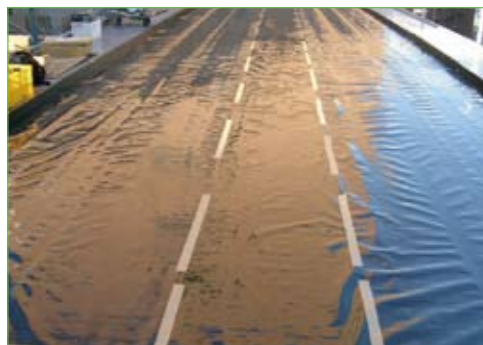
1. 耐根フィルム敷設
