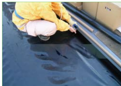
2. 見切り材設置
