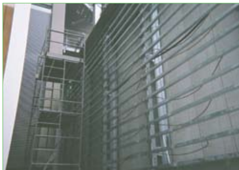
2. 下地架台に灌水ホース敷設
