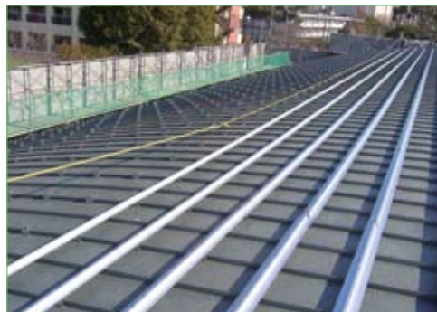
1. 取付金具・下部レール取付
