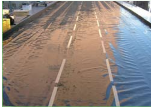
1. 耐根フィルム敷設
