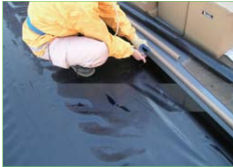
2. 見切り材設置
