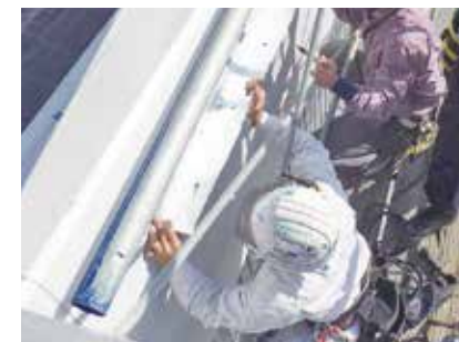
上下取付架台を設置
