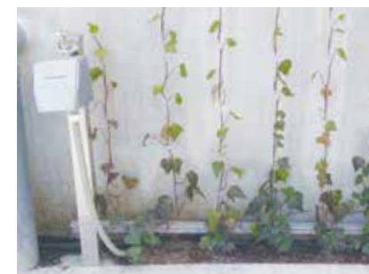
灌水ホース敷設
