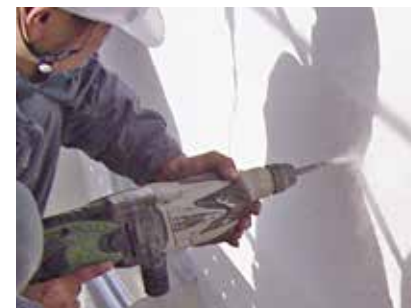
アンカー打ち
