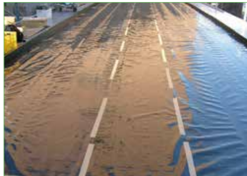
1. 耐根フィルム敷設
