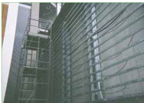
2. 下地架台に灌水ホース敷設
