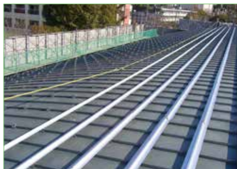
1. 取付金具・下部レール取付
